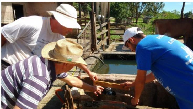
**Figura 3: Instalação do hidrômetro para medição do consumo de água da sala de preparação.**
