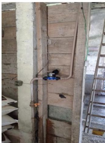
**Figura 2: Instalação do hidrômetro para medição do consumo de água da sala de ordenha.**
